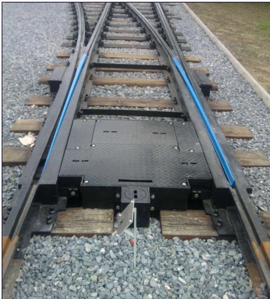
Bloková výměna R50m se zabudovaným výhybkovým systémem
