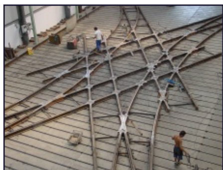
Kolejové křížení ve výrobní hale
