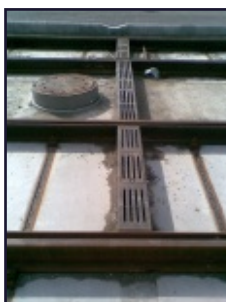
Odvodnění tramvajové trati před zaasfaltováním
