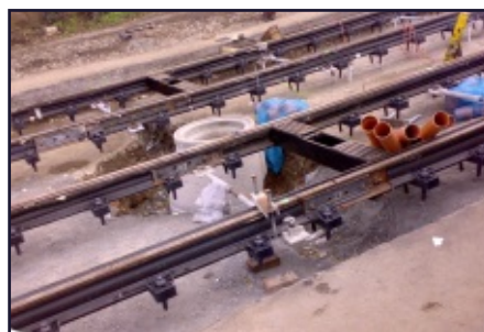
Instalace skříňí odvodnění do rozchodu
