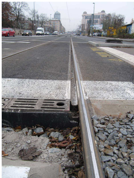
Žlábkovací profil Spurrillenschiene S49 předmontovaný v Pražské strojárně a.s. na betonové pražce a zabudovaný v Praze
