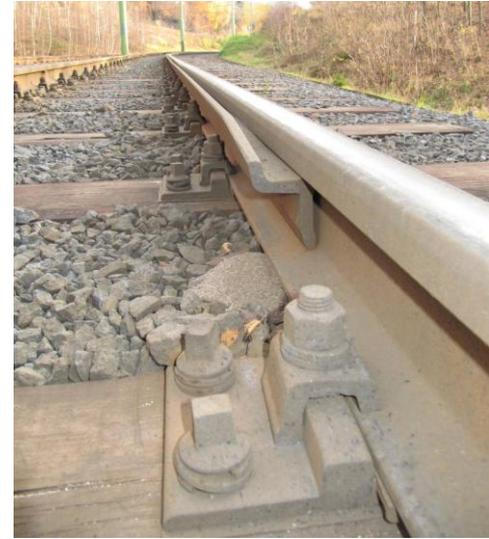
Zwangsschiene aus Spurrillenschiene 49E1-Profil im Bogen in Liberec
