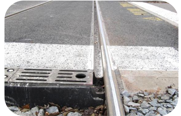
profil Spurrillenschiene 49E1 (Krug)
