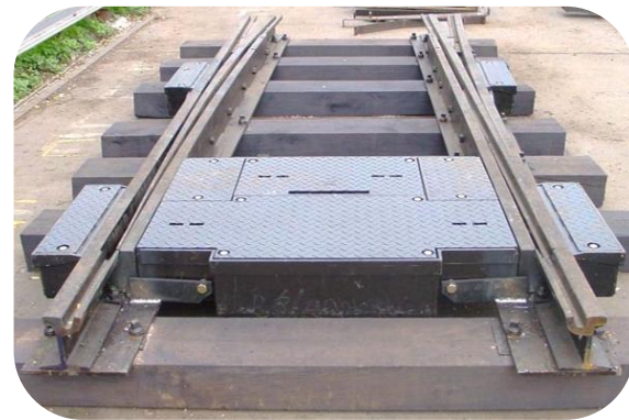
výměny s výměnnými pružnými jazyky
