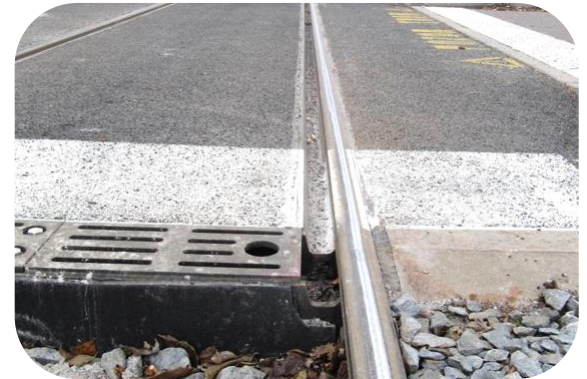
profil Spurrillenschiene 49E1 (Krug)
