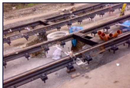
Instalace skříňí odvodnění do rozchodu
