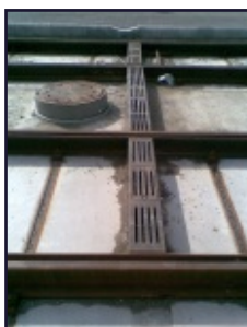
Odvodnění tramvajové trati před zaasfaltováním
