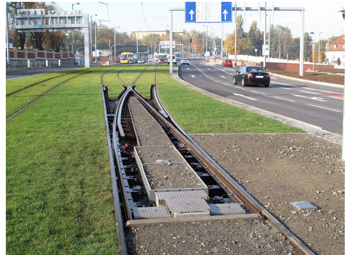
Vignolová výhybka Hradčanská
