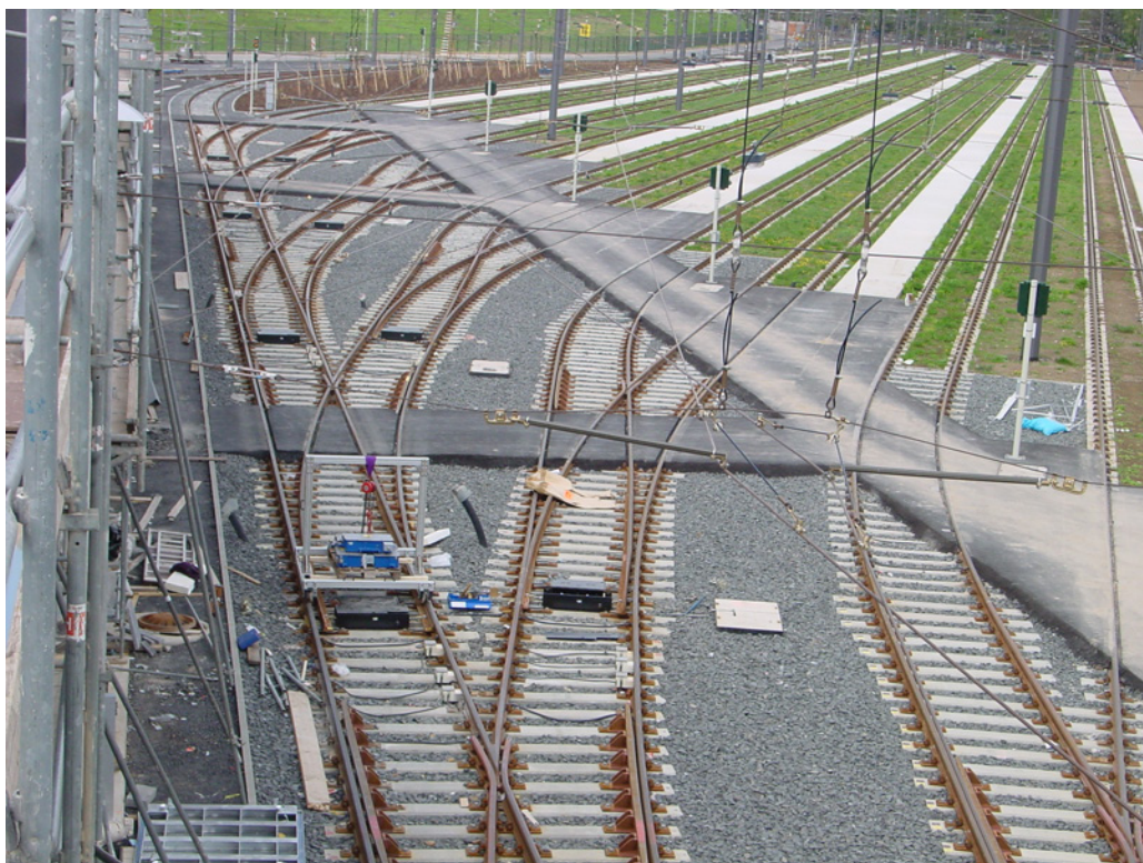
40 ks výhybkových systémů ve vozovně ve Frankfurtu nad Mohanem
