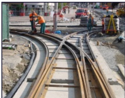
Straßenbahnkreuzung mit zwei Spurweiten in der Stadt Liberec
