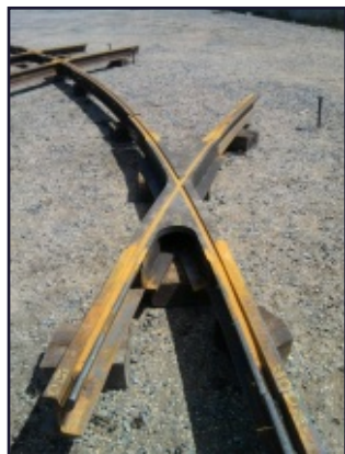
Spezielles geschichtetes Herzstück mit Funktionsteil aus abriebbeständigem Blech HARDOX® 450.
