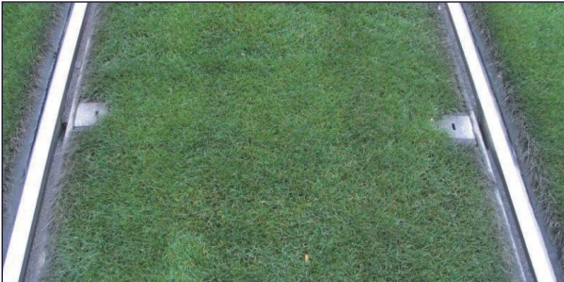
Lösung für begrünte Abschnitte der Straßenbahnstrecken
