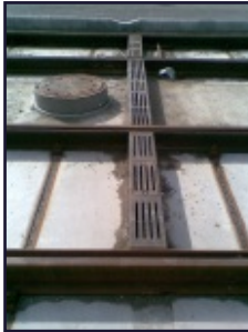
Entwässerung der Straßenbahnstrecke vor dem Asphaltieren
