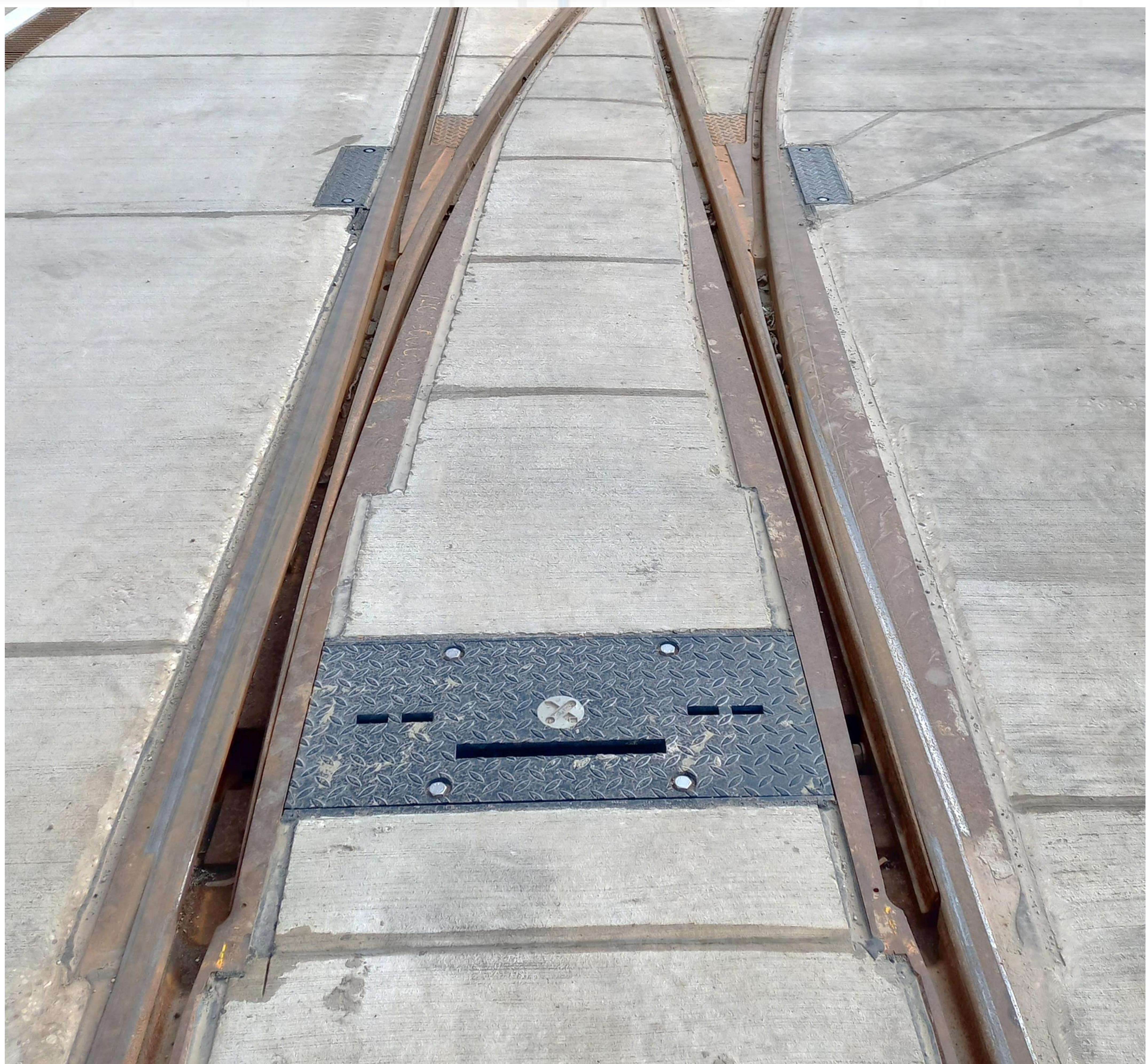
Monoblock-Zungenvorrichtungen werden für linke und rechte Abzweigung hergestellt. Unsere spezielle Konstruktion ermöglicht den Einsatz z. B. für stumpf- oder spitzbefahrene Weichen unter den anspruchsvollsten Bedingungen der Straßenbahngleise.
